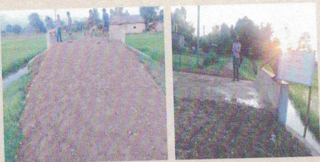
रामपुर देखि घीया जाने बाटोमा कल्भर्ट निर्माण कार्य सम्पन्न भएको
