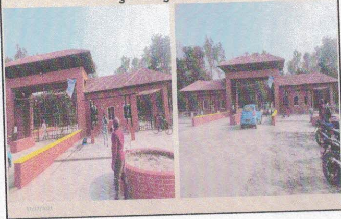
टिकापुर पार्क मुख्य गेट निर्माण
