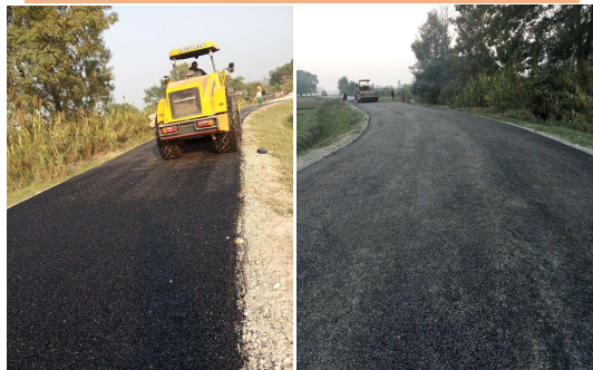
वडा ३ स्थित जमरा पाँकेपुल देखि रामपुर चौराहा सम्मको सडक कालोपत्रे सम्पन्न भैसके पछिको अवस्था
